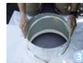
Colerette pare-vapeur d'étanchéité à l'air.
