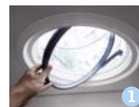
Complément isolant au plafonnier
